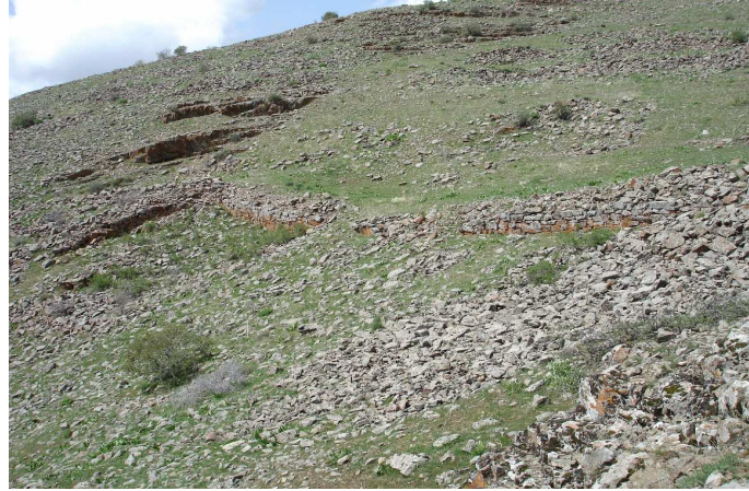
Şəkil 2. Qazançıqalanının qala divarlarının görünüşü.
